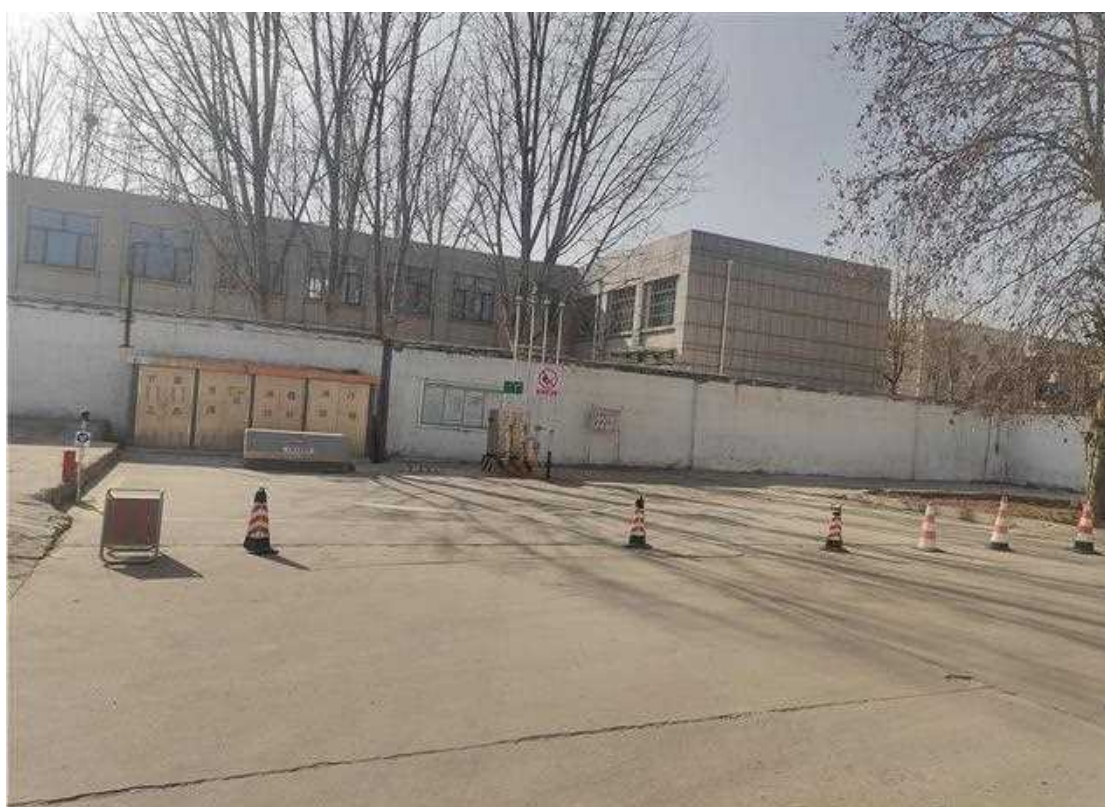
中国石化销售股份有限公司山东济南章丘第二加油站现场照片
