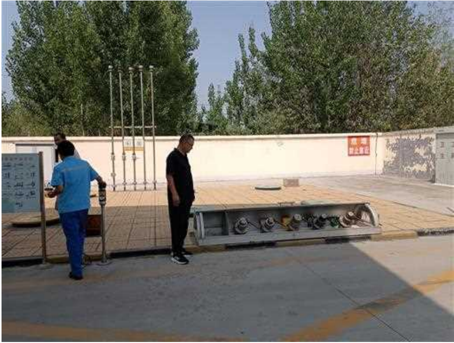
加油站现场照片
