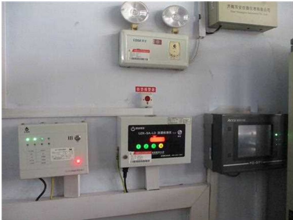
加油站现场照片
