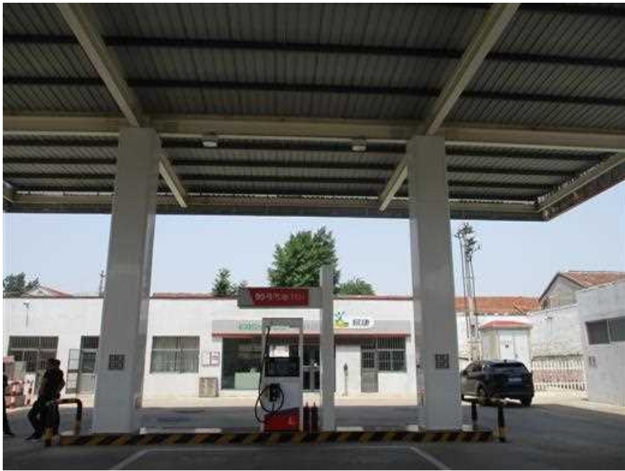
加油站现场照片
