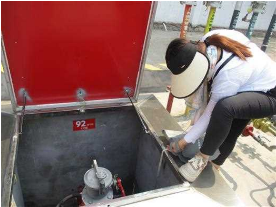
加油站现场照片
