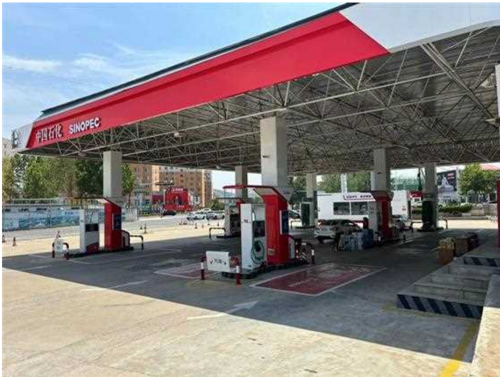
加油站现场照片
