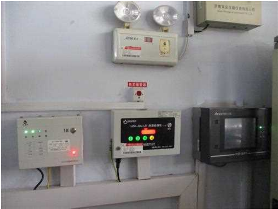
加油站现场照片
