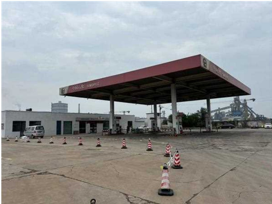
加油站现场照片
