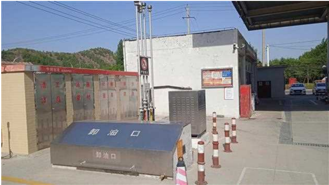
加油站现场照片
