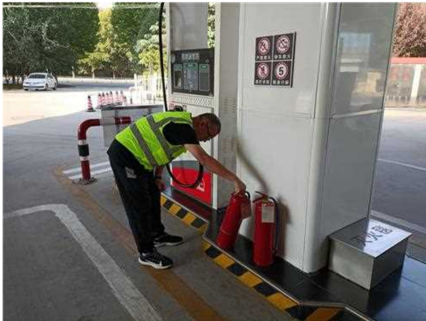
加油站现场照片
