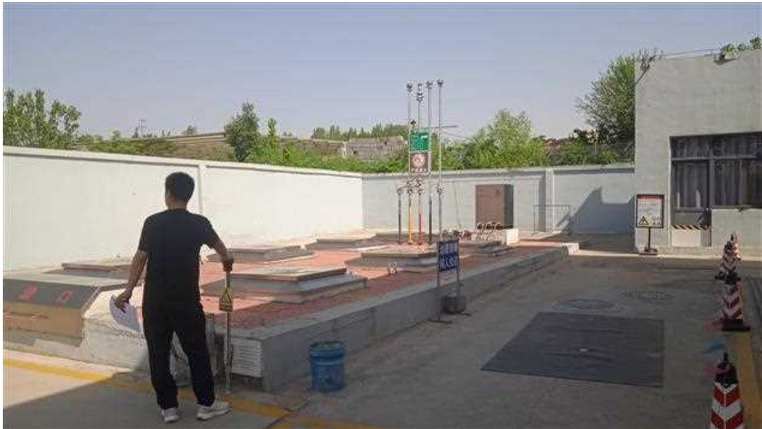
加油站现场照片
