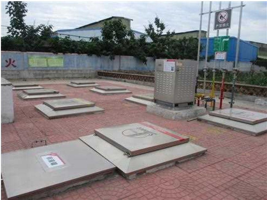
加油站现场照片
