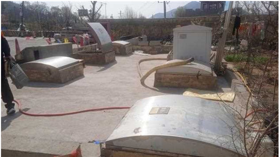
加油站现场照片
