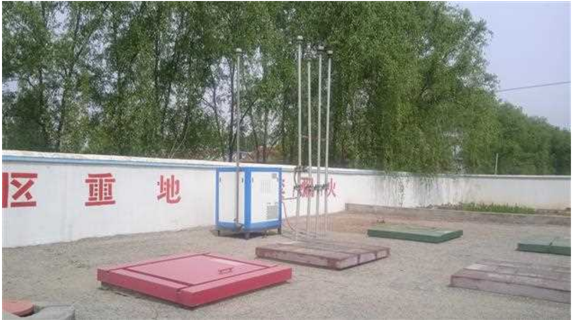
加油站现场照片
