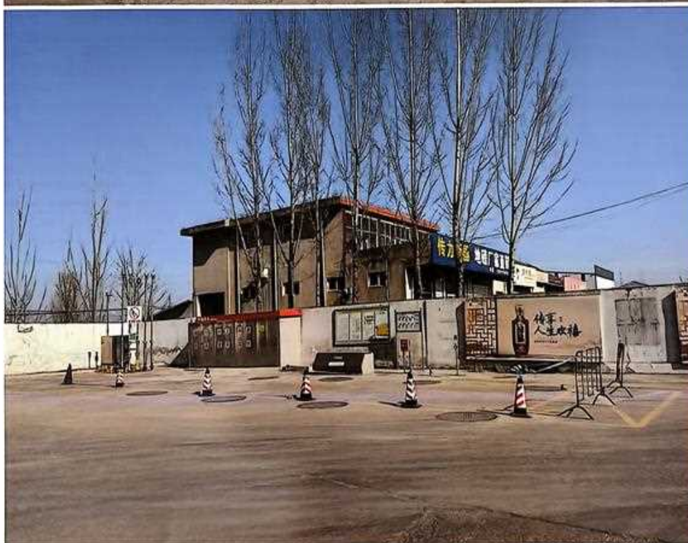
中国石化销售股份有限公司山东济南章丘第十八加油站现场照片
