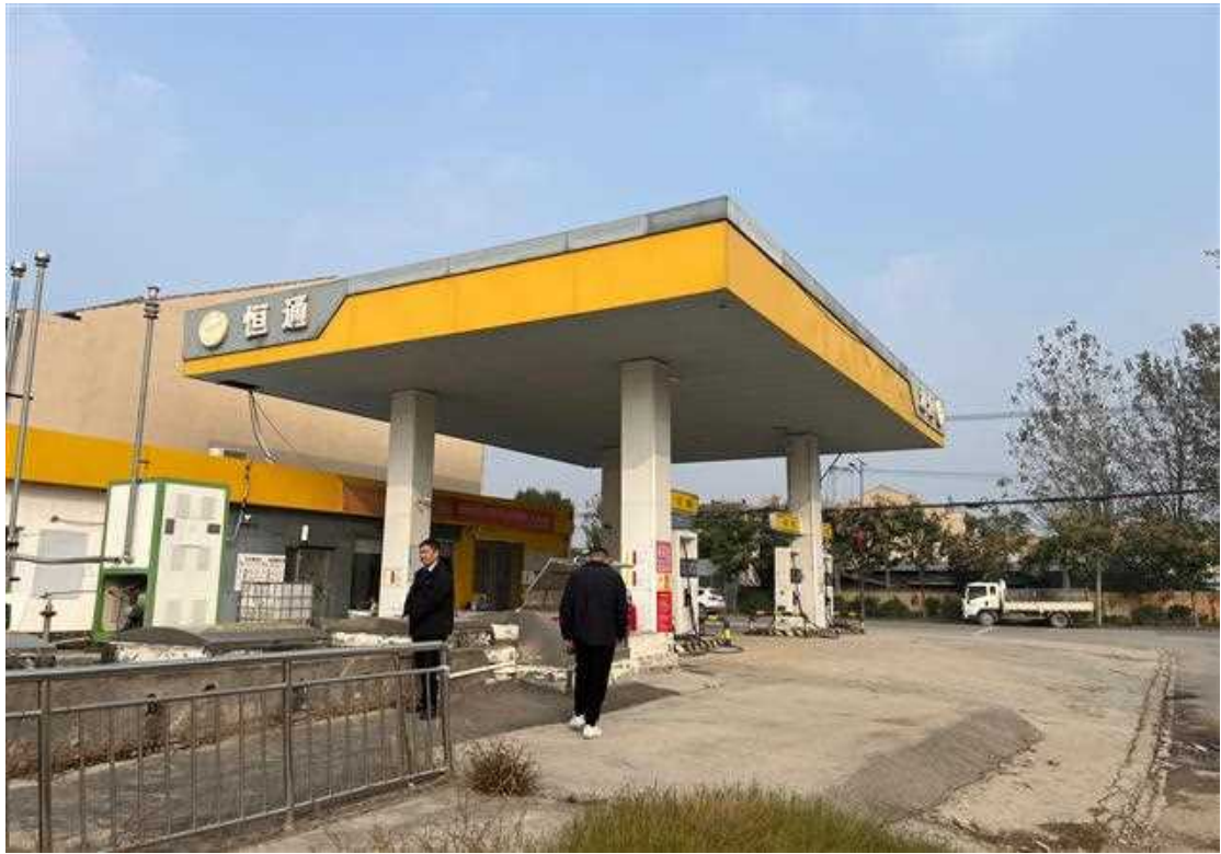
成武县恒通加油站站现场照片
