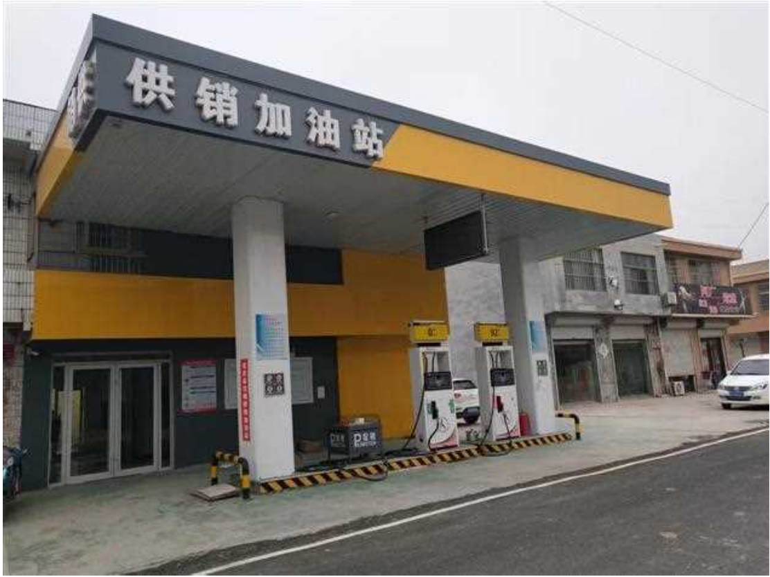
成武县宝峰供销加油站站现场照片
