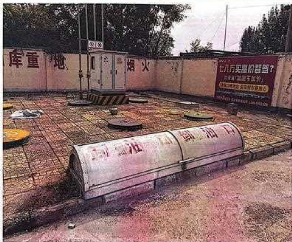
富柏锦石油（江苏）有限公司莱芜分公司加油站现场照片
