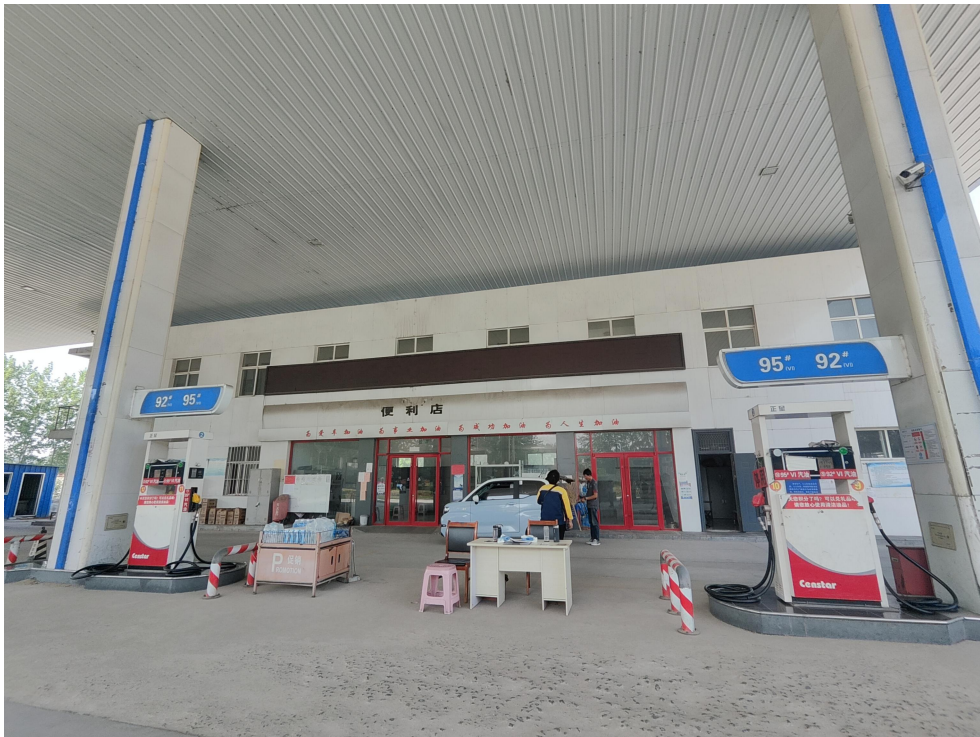
加油站现场照片
