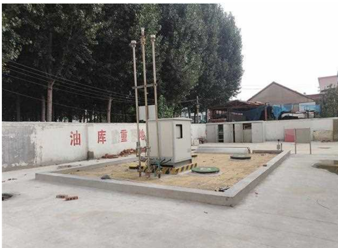
莱芜永顺石油销售有限公司莱芜分公司现场照片
