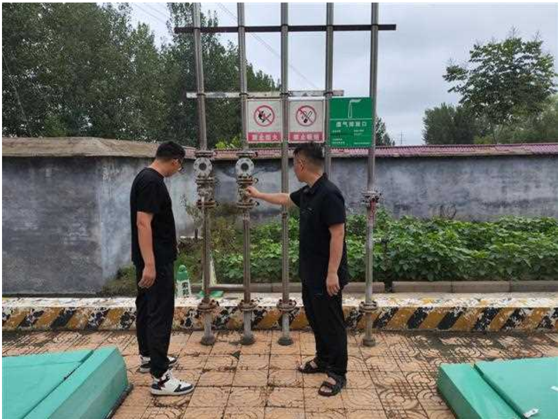
曹县青岛中路加油加气站现场照片
