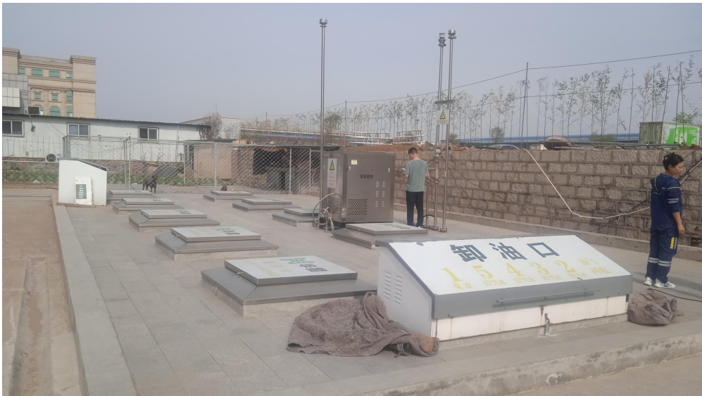
加油站现场照片
