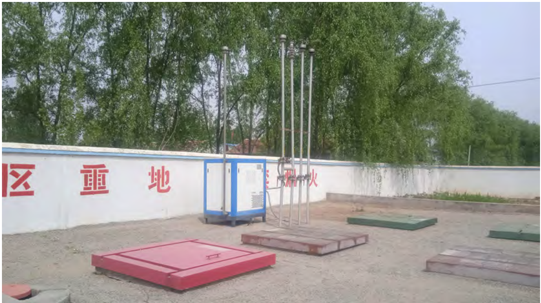
加油站现场照片
