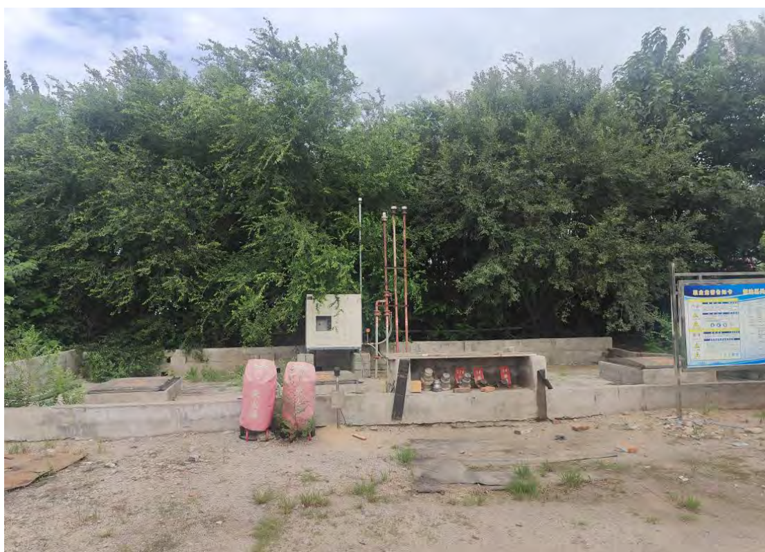
济南市钢城区鲁运石化有限公司现场照片
