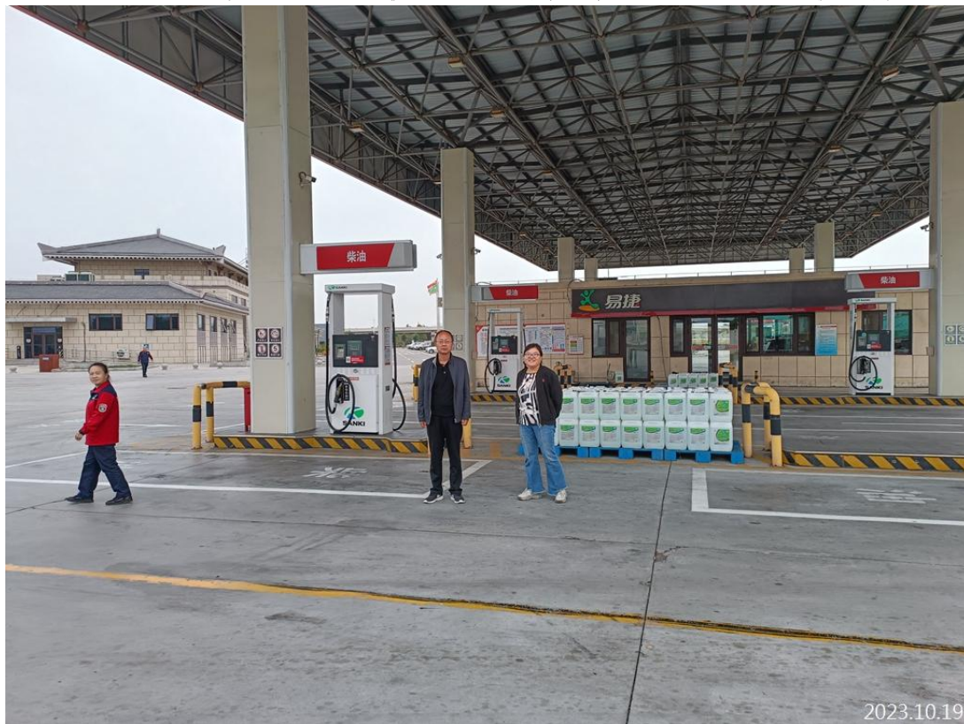
中国石化山东泰山石油股份有限公司高速第四加油站安全现状评价现场照片
