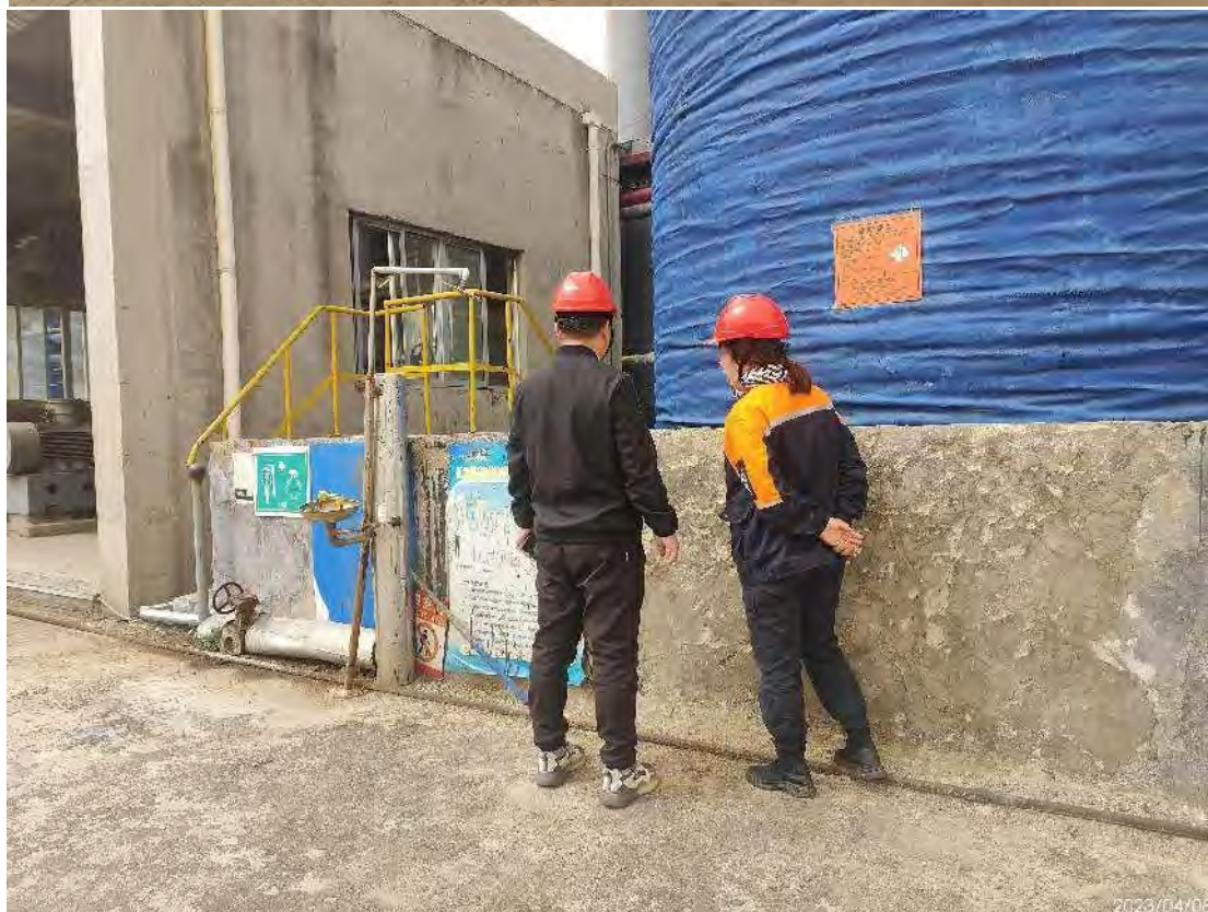
山东固德化工有限公司煤焦油加工项目现场照片
